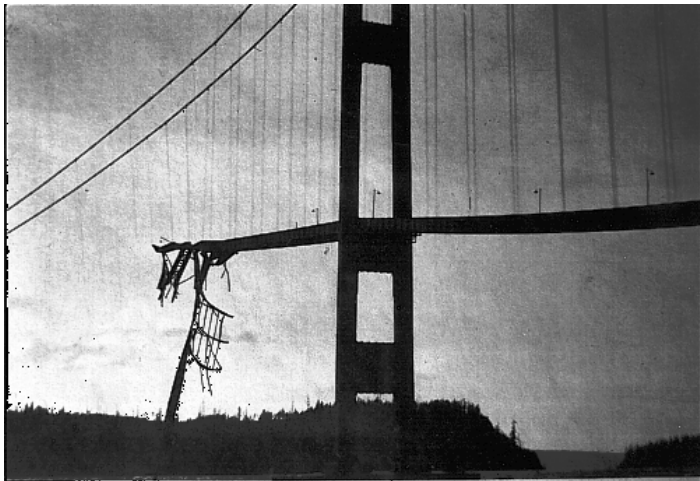
FIGURE 5.6 – Effondrement du pont de Tacoma.
